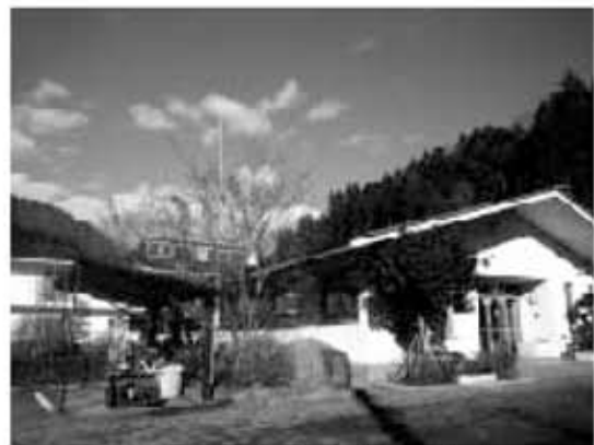
修繕工事が始まった第二皇海荘
