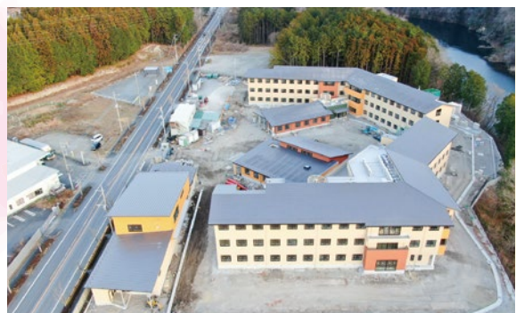
令和6年4月の移転に向け、日光市小佐越地区に建設中の皇海荘・第二皇海荘
